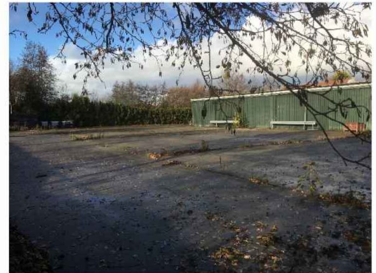
D - zicht op de verhardingen en de bedrijfsgebouwen
