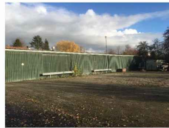
bedrijfsgebouw en verhardingen
