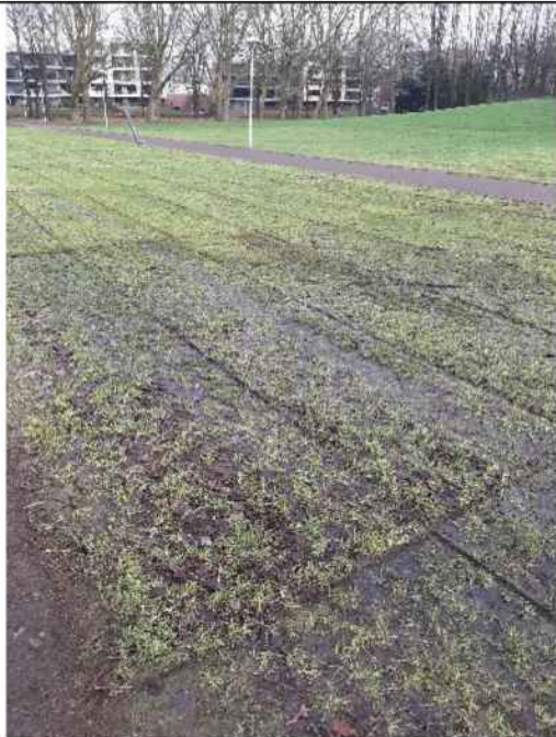
Verdichting als gevolg van het plaatsen van rijplaten grasveld tussen de heuvel en het hoofveld
