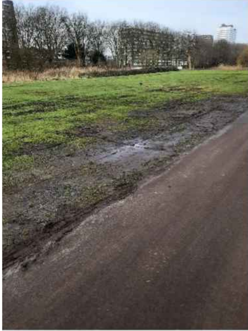
Kale plek met verdichting als gevolg van het plaatsen van rijplaten links naast het hoofdrijbaan
