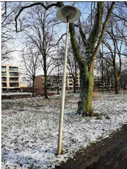
Lichtmast nr.14 staat scheef links langs het pad naast het hoofdveld tussen de platanen.
