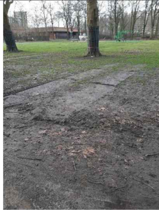
Kale plekken en verdichting als gevolg van het plaatsen van rijplaten op het grasveld met de sporttoestellen
